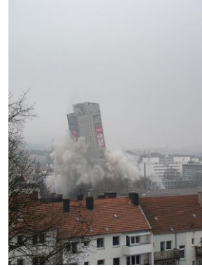
Abb. 2: Sprengung des Langen Oskar in Hagen [2]
