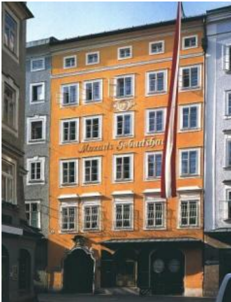
Abb. 9: Die Fassade des Geburtshauses W. A. Mozarts wurde mit einem Silikon imprägniert, um es vor der Witterung zu schützen. [3]
