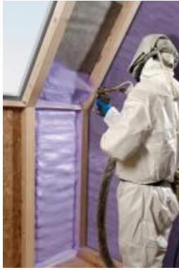
Abb. 9: Anbringen einer Hartschaum-Dämmung durch einen Facharbeiter (beachten Sie die Schutz-Ausrüstung). Dabei wird das anfänglich flüssige Polyurethan an die Wand gesprüht. Dort härtet es aus und bildet den Hart-Schaum. [14]
