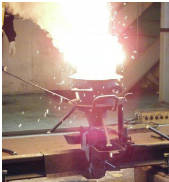
Abb. 2: Schweißen einer Bahn-Schiene nach dem Thermit-Verfahren. Deutlich zu erkennen ist die Heftigkeit der Reaktion [6]
