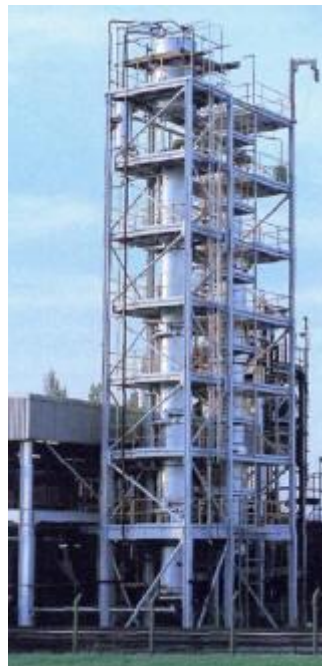
Abb. 9: Turm-Reaktor, Anlage zur Herstellung von Polystyrol [7]
